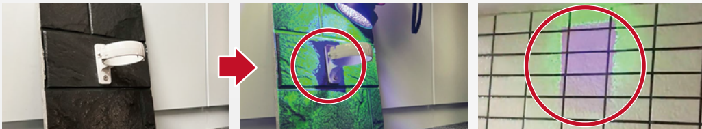
塗装サンプル ブラックライトを当てると紫色の部分が 塗装されていない部分 (塗り洩れを想 定) 蛍光色の部分が塗装されている状況 実塗装での塗り洩れ状況 紫色の部分が塗り洩れ箇所
